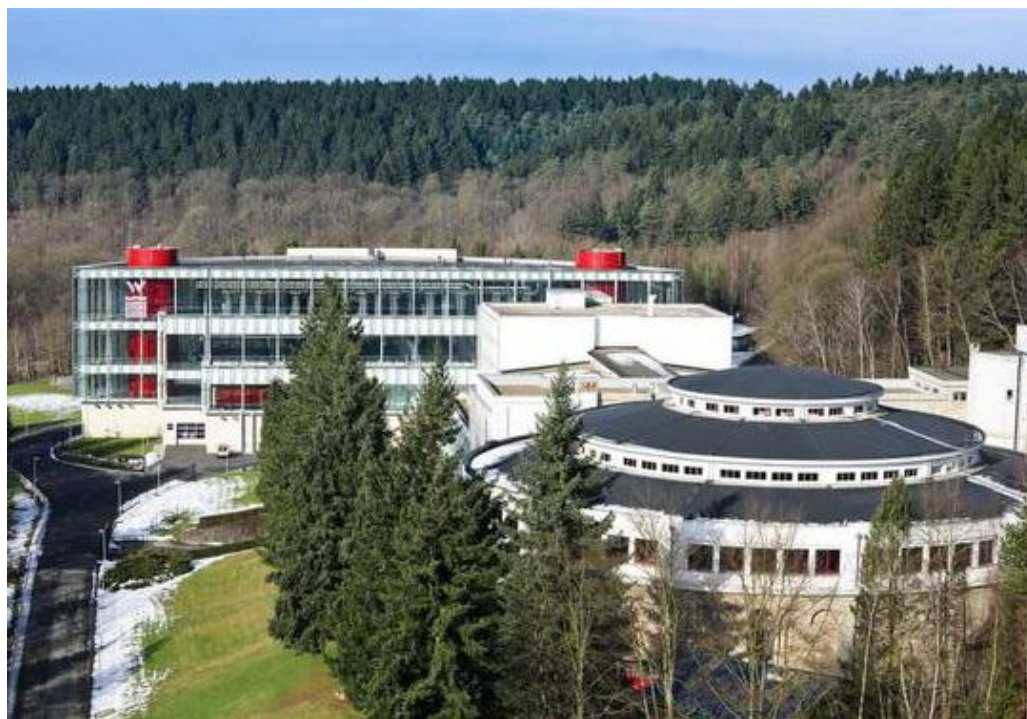
La station de potabilisation d'Eupen. © D.R.
