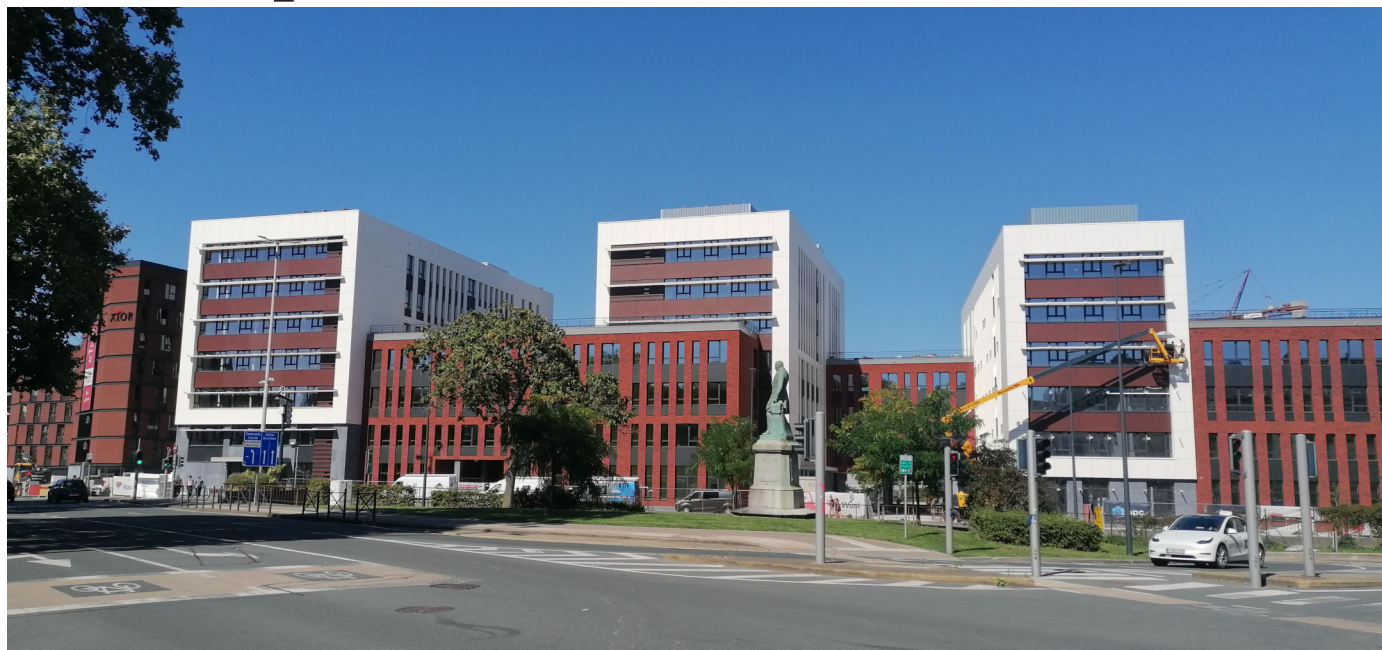
Cap Sud, futur siège du Secrétariat général du SPW à Namur, à côté de la gare. © D.R.
