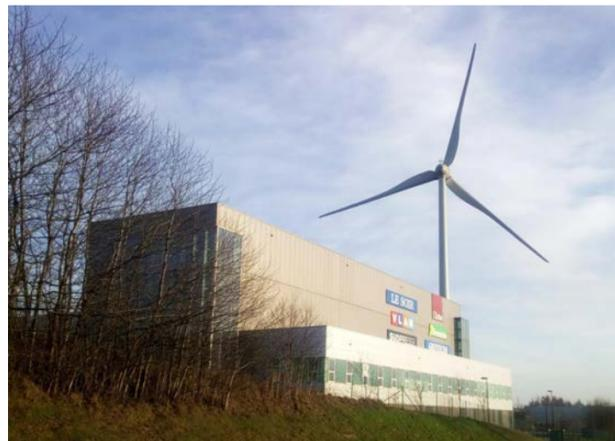
Outre l'installation d'une cogénération de gaz sur le site de Nivelles, une éolienne raccordée à la cabine de haute tension de l'imprimerie permet d'alimenter en électricité la rotative et les bureaux. © D.R.
