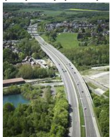
Grâce aux profils techniques de ses différents départements, le SPW Mobilité Infrastructures peut fournir une route sécurisée pour les usagers. ► SPW
