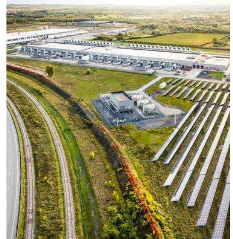
Des postes techniques, comme celui d'ingénieur électricien ou de technicien de maintenance en mécanique de refroidissement, sont actuellement ouverts. Le site a en effet été conçu pour avoir une faible consommation énergétique, avec toutes les spécificités techniques que cela implique. ► D.R.
